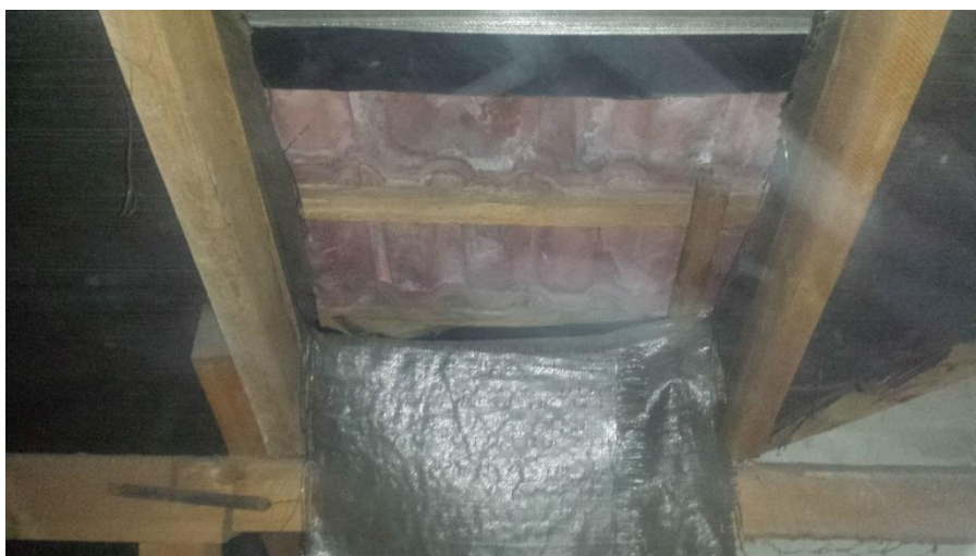
Rys. 5. Uszkodzenie wiatroizolacji. [1.4.].
