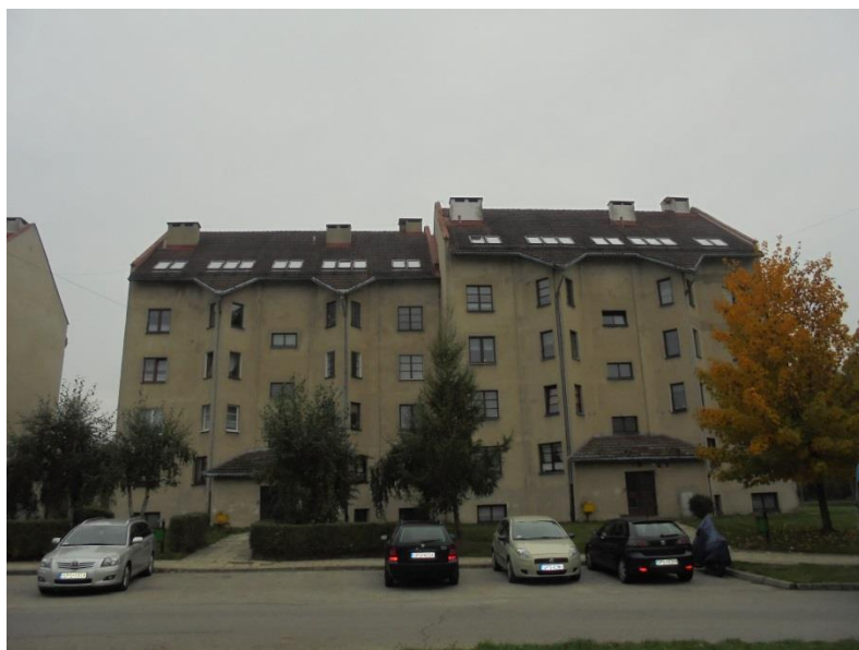
Rys. nr 2. Widok ogólny budynku przy ul. Słonecznej 16,18 w Woli – elewacja północno-wschodnia [1.4.].
