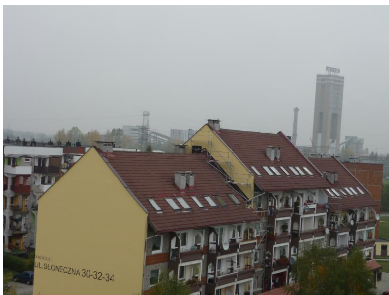
Rys. nr 6. Zabrudzenia na powierzchni dachu 1.4.]
