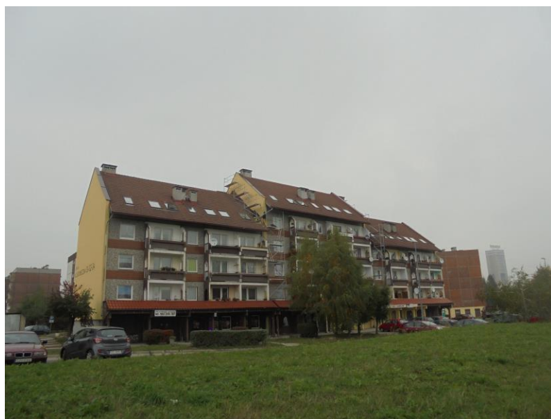
Rys. nr 3. Widok ogólny budynku przy ul. Słonecznej 30,32,34 w Woli – elewacja południowa [1.4].
